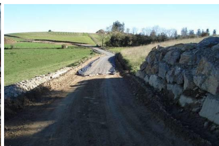
Mise en place du gravier
