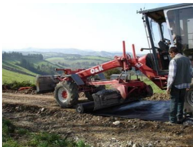
Pose du géotextile
