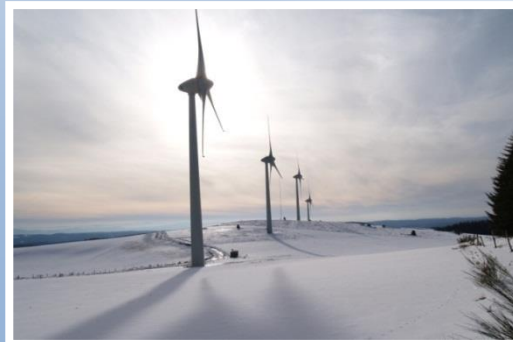
Pôle éolien des MONTS DE LACAUNE Département : Tarn (81), Aveyron (12) Puissance électrique : 74 MW 31 éoliennes, 6 parcs Mise en service : 2006-2008-2011
