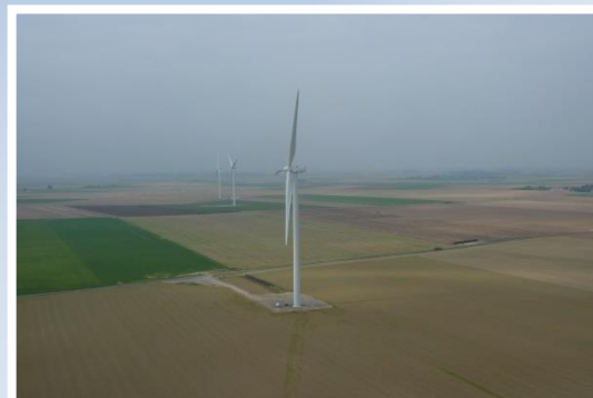
Parc de CHAMPS PERDUS Département : Somme (80) Puissance électrique : 12 MW 4 éoliennes Mise en service : 2014
